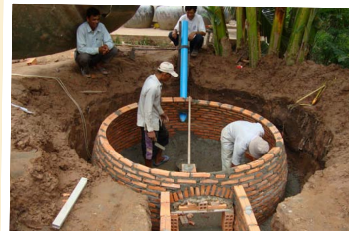
STAVBA BIOPLYNÁRNY (ARCHIV ČVT)
